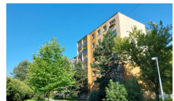
Družstevní byt 3+1, ul. Ostravská, Český Těšín
