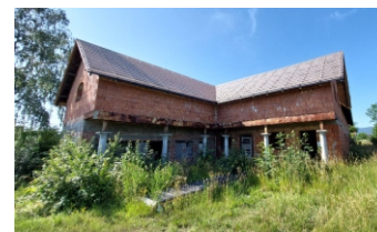
Rozestavěná stavba víceúčelového objektu, Třinec-Nebory
