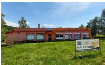
Komerční objekt, Č. Těšín - Stanislavice
