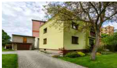
RD Český Těšín, ul. Žukovská
